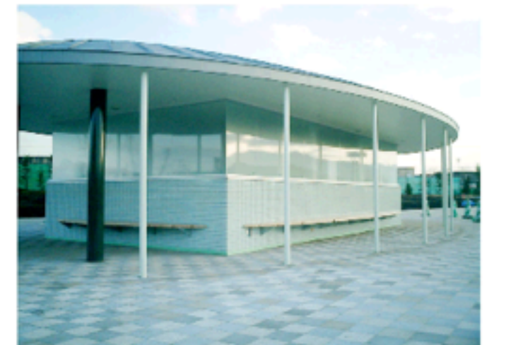
石狩市ふれあいの杜公園トイレ
