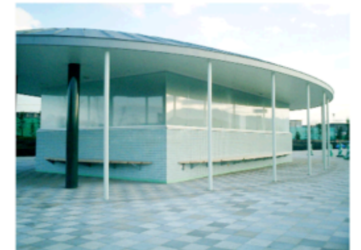
石狩市ふれあいの杜公園トイレ
